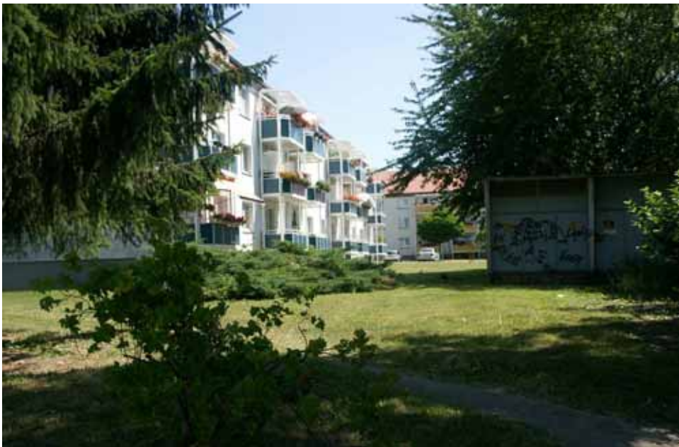
Dreigeschossige Wohnzeilen in der Wohnsiedlung Süd
