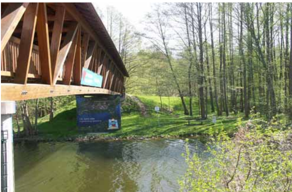
Fußgängerbrücke zum Havelpark, Fürstenberg /Havel
