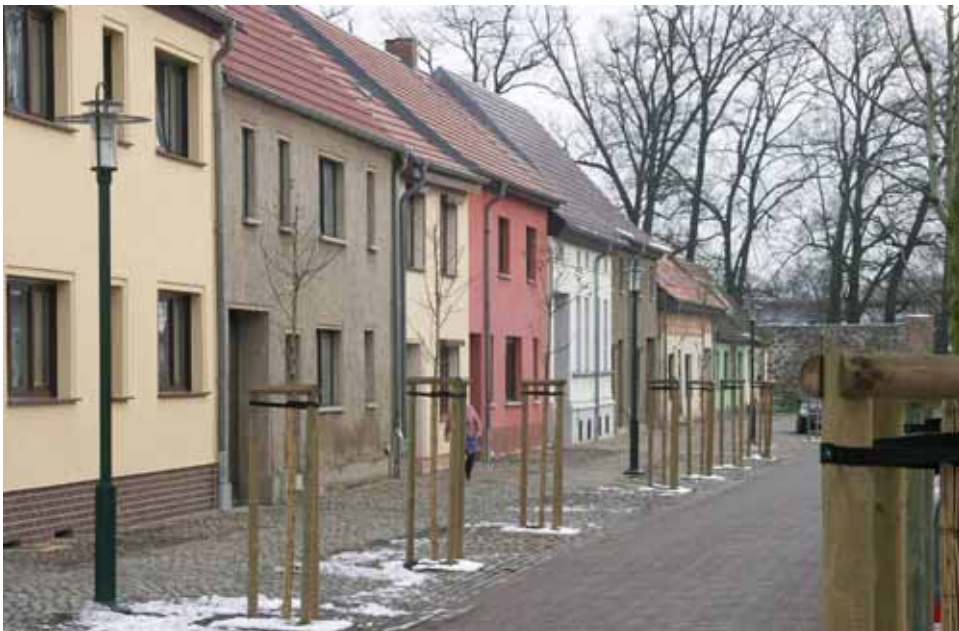
Typische zweigeschossige Wohnhäuser in einer Seitenstraße der Altstadt
