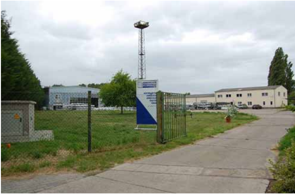
Fensterbaubetrieb im Bereich des früheren Hebelwerkes
