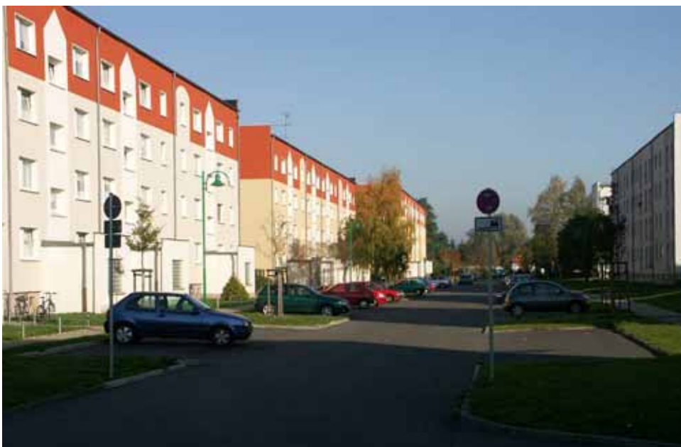
Viergeschossige Wohnzeilen in der Wohnsiedlung Süd
